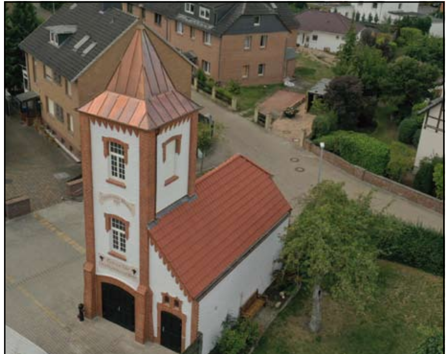
Das sanierte Spritzenhaus im August 2019.
