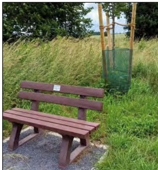
Karsten Heine Bau GmbH Höver erstellte das Fundament für die Bank.
