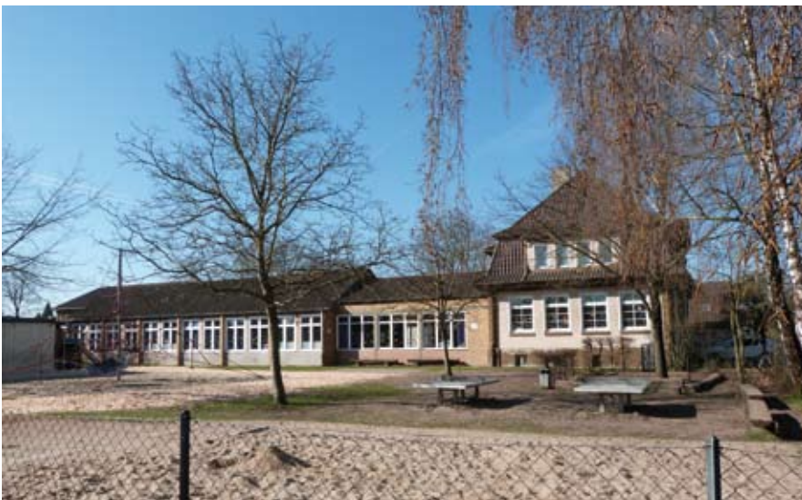
Die Grundschule Höver vom Pausenhof aus gesehen: ganz links die mobilen Raumeinheiten (2017) dann die Klassenräume und die Eingangshalle (1959) und das alte Hauptgebäude (1922).
